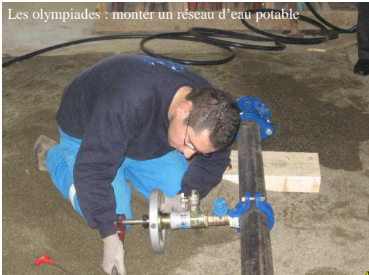
Les olympiades : monter un réseau d'eau potable
